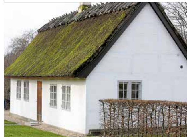
Rendelæggerhuset er fra 1725, men blev for 10 år siden renoveret. Foto: Anna Hjortsø
